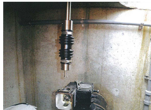
■ 新規インプットシャフト取付け
