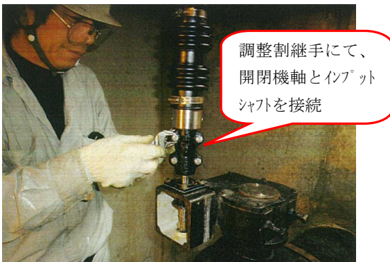
■ 開閉器軸とインプットシャフトを接続
