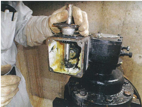
■ 既設インプットシャフト取り外し
