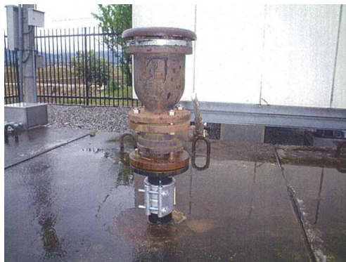
■アトムズカップリング取付け完了
