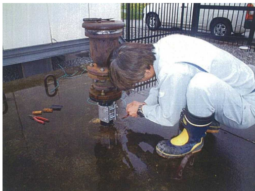
■アトムズカップリング取付け状況
