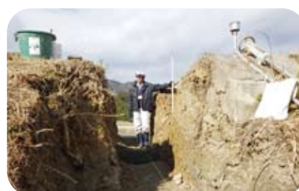
堤体掘削断面確認
