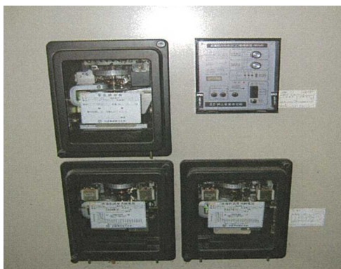
■SOG（継電器）制御装置（遠景）
