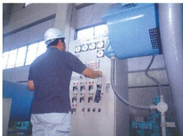
日常巡視点検
