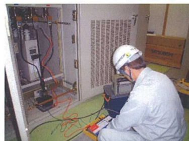
高圧絶縁測定
