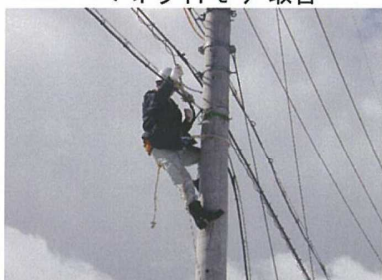
通信ケーブル移設
