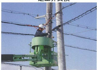
通信ケーブル移設
