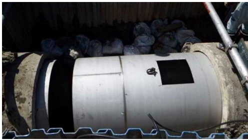
■鋼管設置完了
