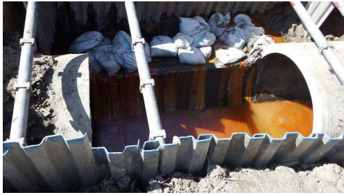
■破損管上部半管撤去
