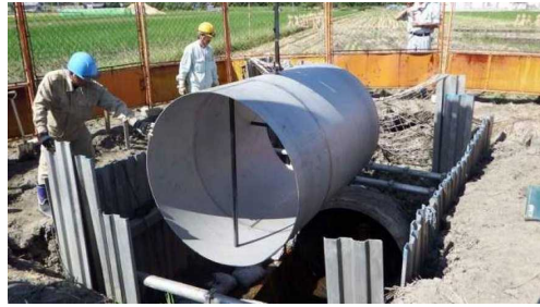
■鋼管釣り込み状況
