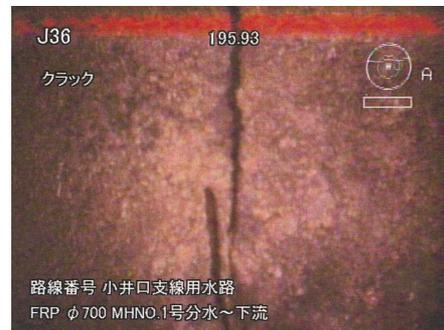
■管内漏水箇所（ズレ、隙間）
