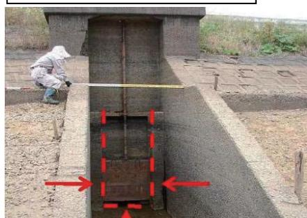
写真 38：取水部周辺の土砂やゴミの堆積
