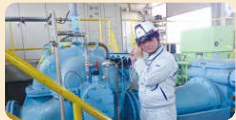
ポンプ振動測定
