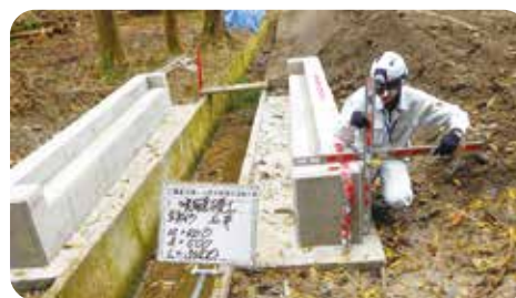
床版基礎出来高確認
