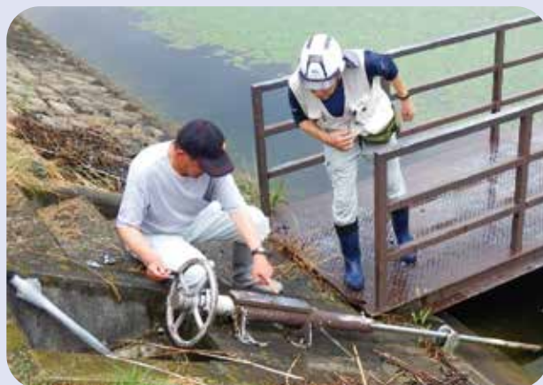
ため池点検・パトロール(取水施設作動確認)
