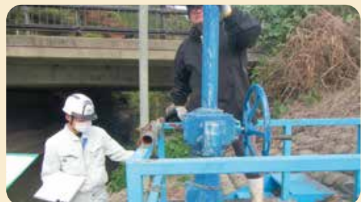
樋門ゲート点検
