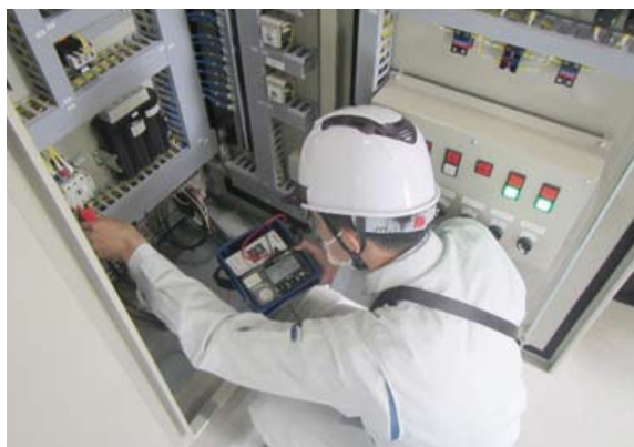
揚水機電気設備の診断
