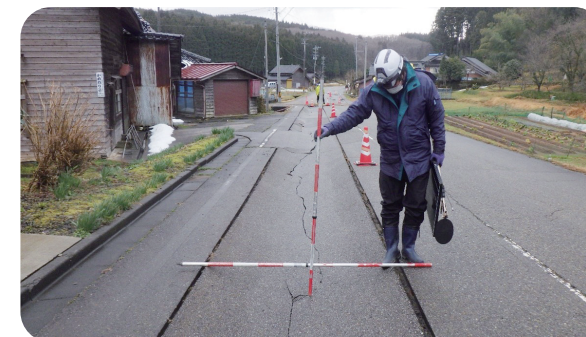
管路の沈下量測定
