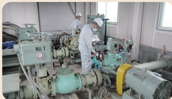
揚水ポンプの診断
