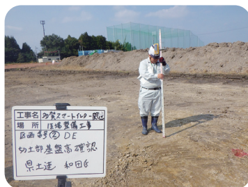
基盤標高を確認し、施工方法を検討
