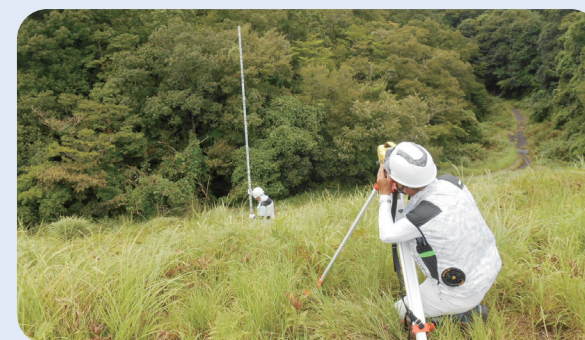
堤体測量(調査点検支援業務)
