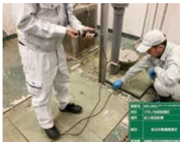
農業集落排水施設 硫化水素濃度測定
